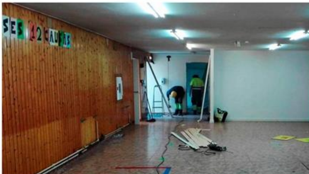
Trabajos de adecuación del local de Asпамite. Foto: Asпамite
